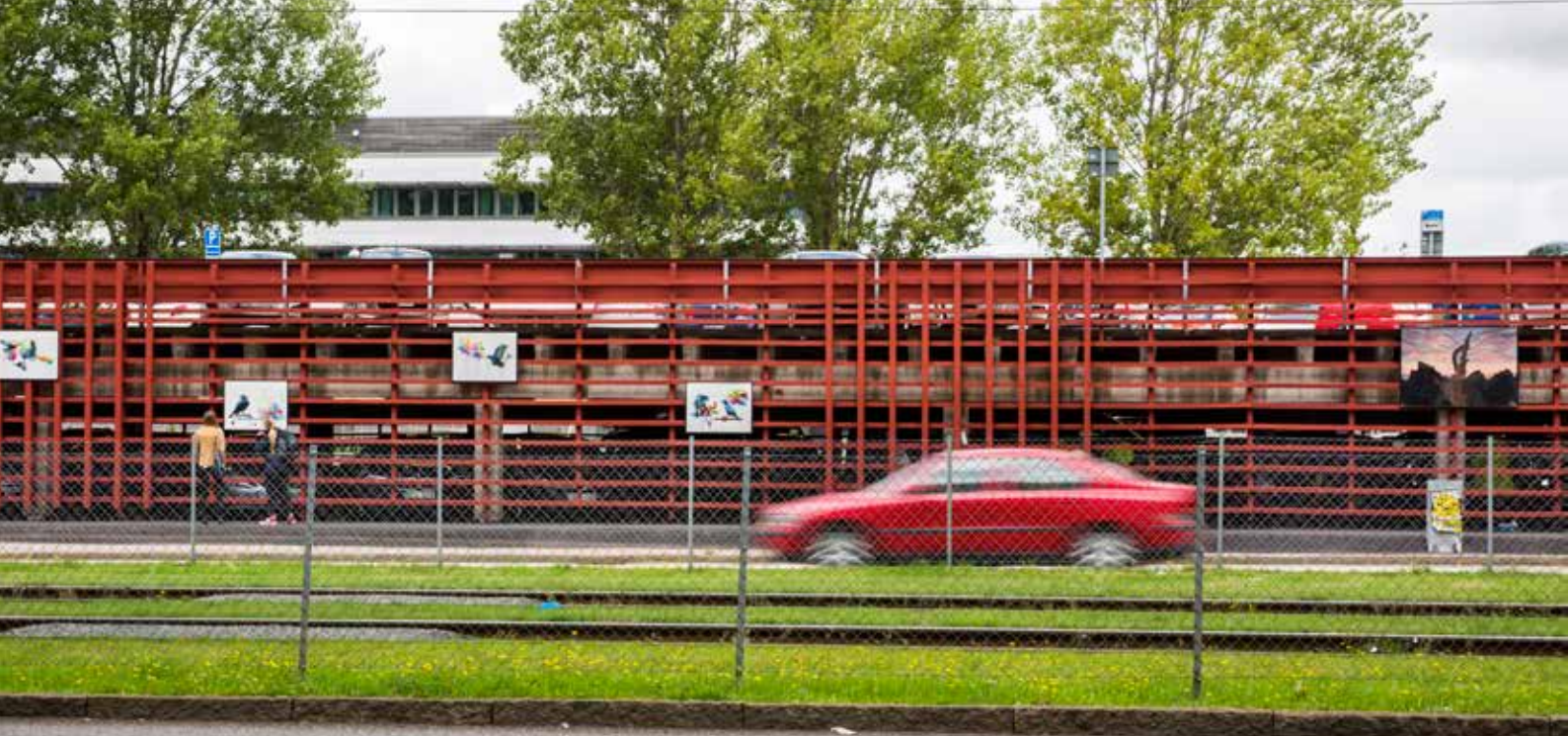
Fasaden på Nordhemsgatan Snipan P-hus mot Första Långgatan har smyckats med 18 olika konstverk gjorda av sex olika konstnärer. Utställningen är tänkt att inspirera människorna som passerar och skapa en mer spännande stadsmiljö i området.
